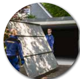
Demontage en milieuvriendelijke verwijdering
